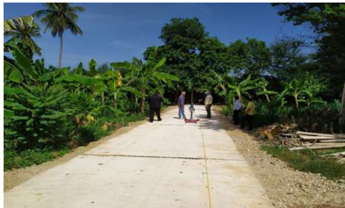
โครงการก่อสร้างถนน ค.ส.ล.สายหนองไถ่แก้ว หมู่ที่ 3
