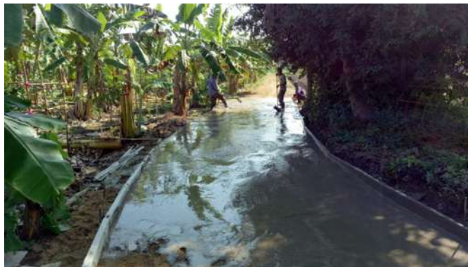
โครงการก่อสร้างถนน ค.ส.ล. ซอยบ้านนายเมิน ม่วงน้อย (ช่วงที่ 2) หมู่ที่ 7
